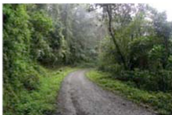
Carretera de acceso (José Castaño)
