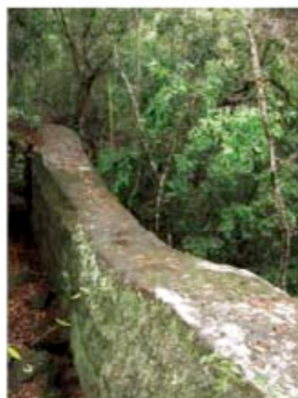
Muro de piedra
